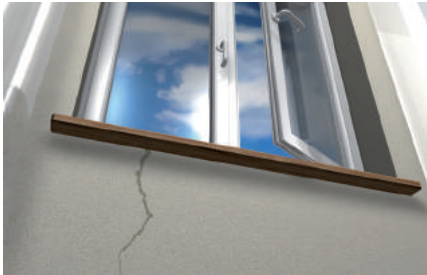
Uszczelnianie rys i pęknięć
