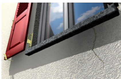
Uszczelnianie rys i pęknięć
