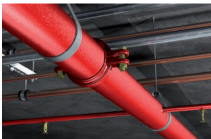
Mocowanie instalacji tryskaczowych
