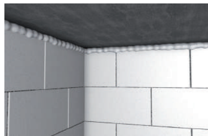
Uszczelnianie złączy liniowych
