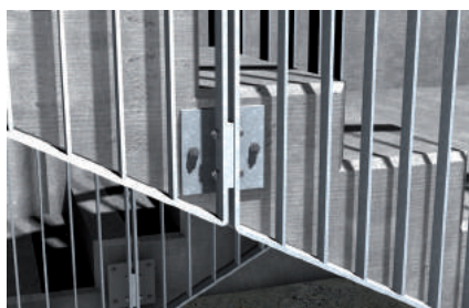
Mocowanie balustrad i poręczy
